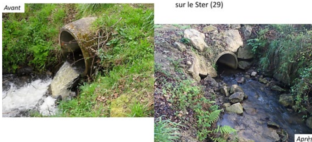
Aménagements sur l'ouvrage de St Alour sur le Ster (29)
