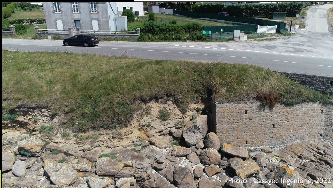
Falaise meuble et mur de soutènement au Porsmeur à Porspoder
