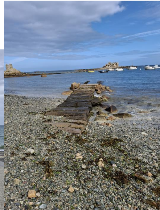
ROE56461 - Ouvrage de connexion des marais de Launay (22)
