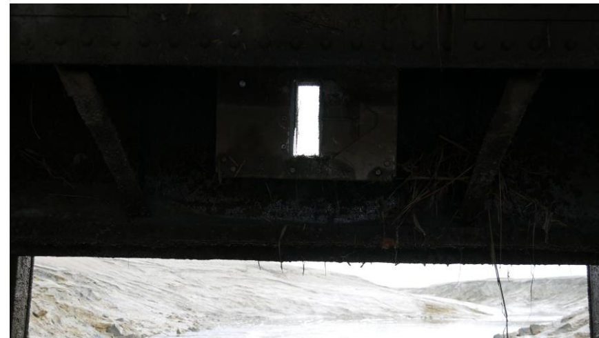
Vantelles sur l'ouvrage du Canal des allemands (35)
